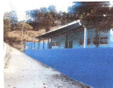
Foto 6: MUROS PERIMETRALES (REPARACIÓN DE MURO PERIMETRAL DE BLOCK CON TUBO HG Y MALLA GALVANIZADA Y SOLERAS INTERMEDIAS)
