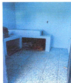
Foto 2: PISO (sustitución de torta de concreto en mal estado de cocina y dos baños)
