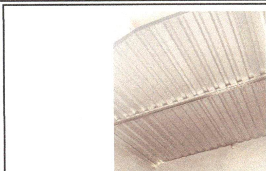
Foto 1: CUBIERTA DE LÁMINA (sustitución de láminas y estructura de madera en mal estado del techo de la cocina)
