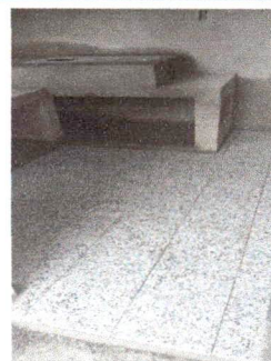
Foto 2: PISO (sustitución de torta de concreto en mal estado de cocina y dos baños)
