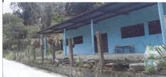
Foto 6: MUROS PERIMETRALES (REPARACIÓN DE MURO PERIMETRAL DE BLOCK CON TUBO HC Y MALLA GALBANIZADA Y SOLERAS INTERMEDIAS)
