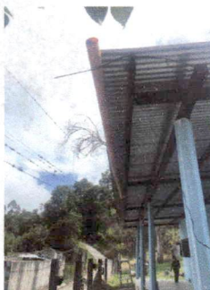
Foto 3: CANALES Y BAJADAS DE AGUA PLUVIAL (canales y bajada de agua pluvial en mal estado)
