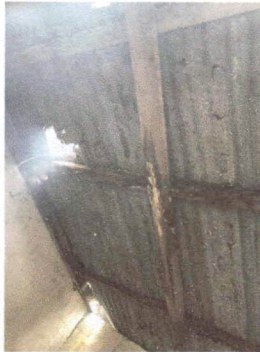
Foto 1: CUBIERTA DE LÁMINA (sustitución de láminas y estructura de madera en mal estado del techo de la cocina)
