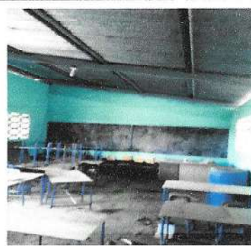
Foto 2: Pintura en muros exteriores e interiores
