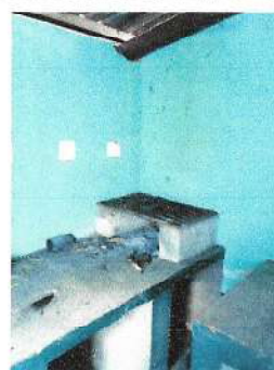
Foto 4: Pintura en muros exteriores e interiores
