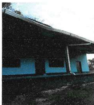
Foto 5: Sustitución de canal de metal
