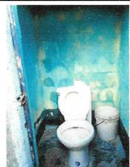
Foto 5: Pintura en muros exteriores e interiores
