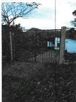
Foto 1: Mantenimiento a portones de metal
