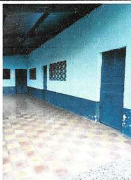
Foto1: Pintura en muros exteriores e interiores
