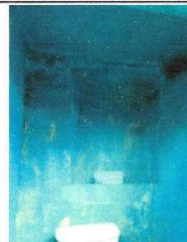
Foto 4: Pintura en muros exteriores e interiores
