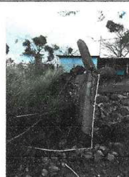
Foto 4: Reparación de muro perimetral de block con tubo hg y malla galvanizada, soleras intermedias y columnas.
