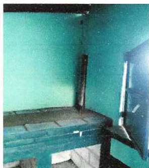
Foto 1: Mantenimiento a estructura de metal de ventana
