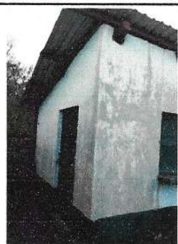
Foto 5: Pintura en muros exteriores e interiores
