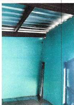
Foto 3: Sustitución de tubo de chimenea de metal
