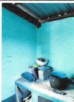
Foto 3: Pintura en muros exteriores e interiores
