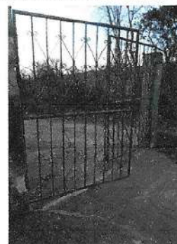
Foto 2: Mantenimiento a portones de metal
