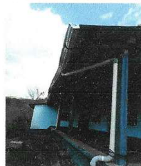
Foto 6: Sustitución de canal de metal
