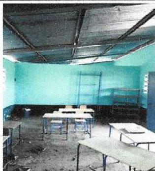
Foto 1: Pintura en muros exteriores e interiores
