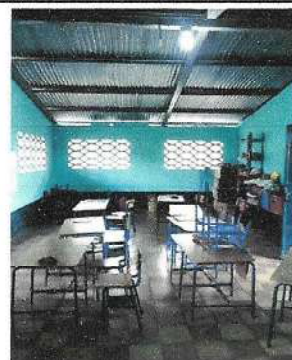
Foto 4: Pintura en muros exteriores e interiores
