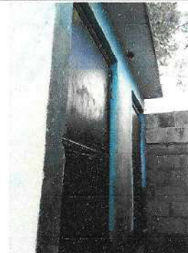
Foto 2: Pintura en muros exteriores e interiores
