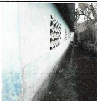
Foto 5: Pintura en muros exteriores e interiores
