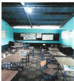
Foto 3: Pintura en muros exteriores e interiores
