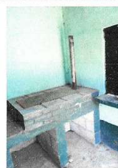
Foto 4: Sustitución de tubo de chimenea de metal
