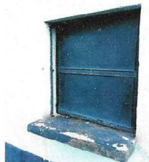
Foto 2: Mantenimiento a estructura de metal de ventana
