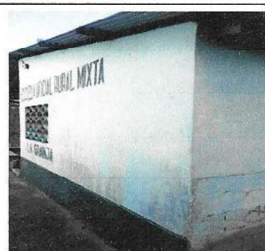
Foto 6: Pintura en muros exteriores e interiores
