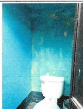
Foto 3: Pintura en muros exteriores e interiores
