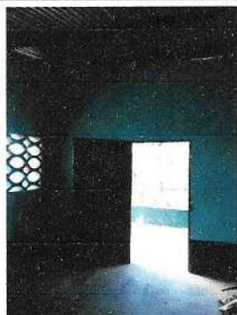
Foto 1: Pintura en muros exteriores e interiores
