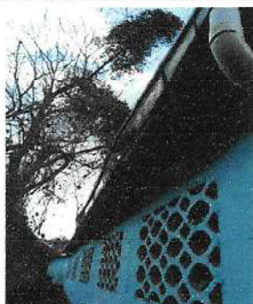
Foto 1: Reparación de bajada de agua pluvial, tubo PVC 3"
