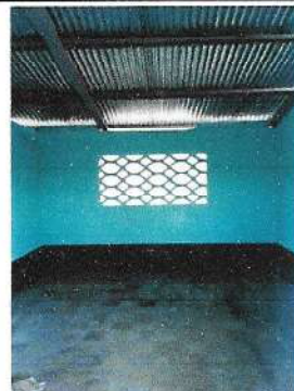
Foto 2: Pintura en muros exteriores e interiores
