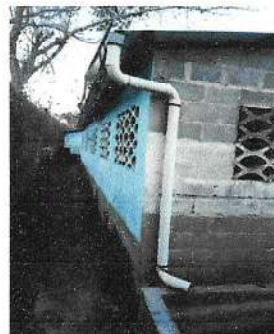
Foto 2: Reparación de bajada de agua pluvial, tubo PVC 3"
