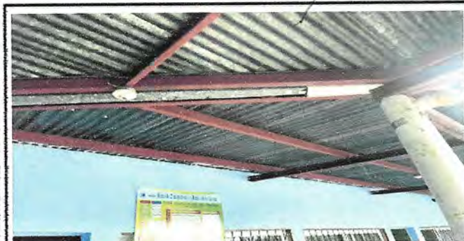
Foto 2: ESTRUCTURA DE TECHO
