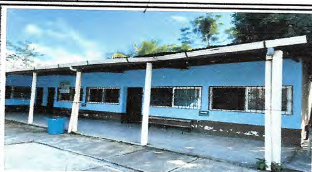
Foto 5.1: CANALES Y BAJADAS DE AGUA PLUVIAL
