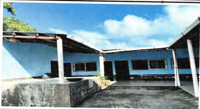
Foto 5: CANALES Y BAJADAS DE AGUA PLUVIAL
