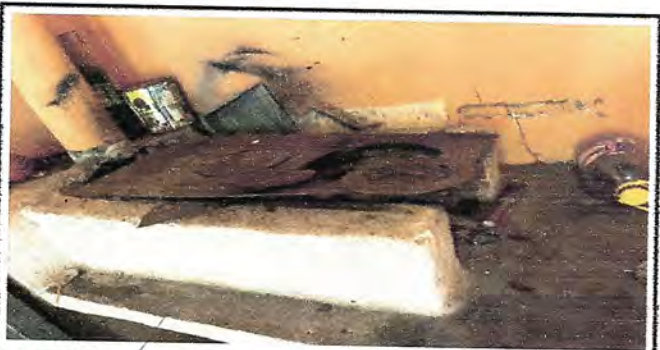
Foto 9: REPARACION DE COCINA
