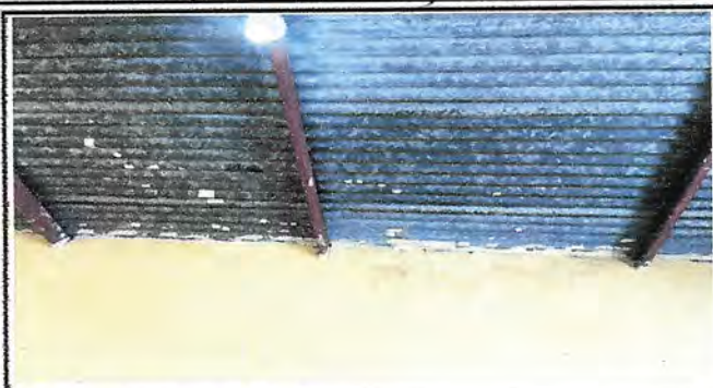
Foto1: CUBIERTA DE LAMINA
