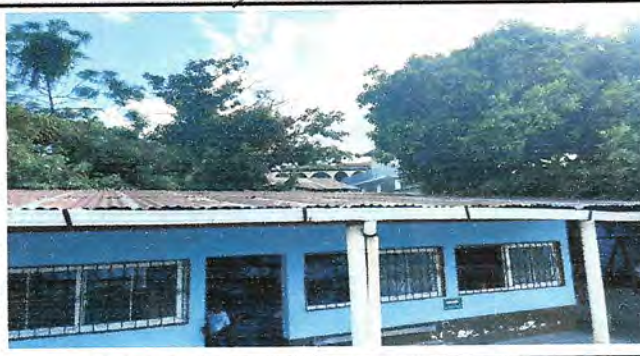
Foto 1.1: CUBIERTA DE LAMINA
