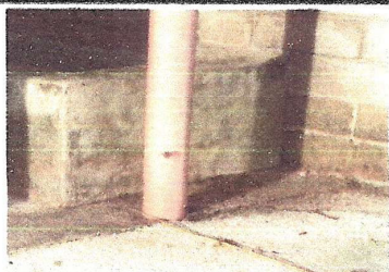
Foto 5: Instalación de pila
