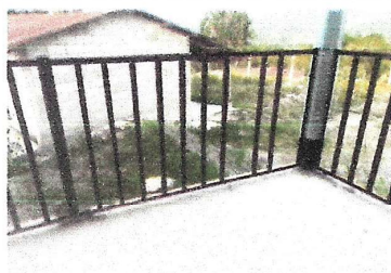
Foto 3: Mantenimiento de baranda
