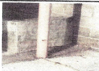
Foto 5: Instalación de pila
