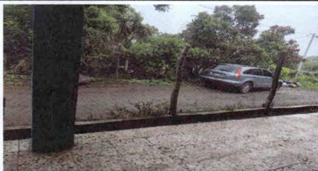
Foto 1: Reparación muro perimetral de block con tubo hg y malla galvanizada, soleras intermedias y columnas.
