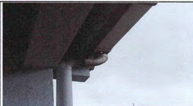
Foto 2: Sustitución de canal de PVC
