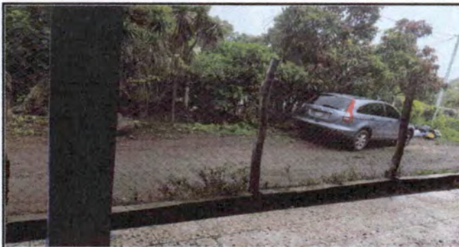
Foto 4 : Reparación muro perimetral de block con tubo hg y malla galvanizada, soleras intermedias y columnas.
