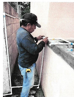
Foto 6: instalación de tubería de Agua
