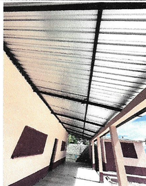
Foto 2: Restauración de estructura e instalación de lamina
