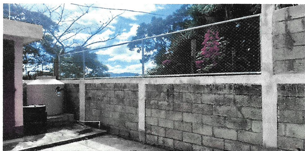
Foto 3: cerco de malla
