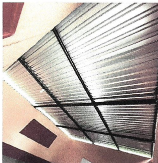
Foto 1: desmontaje de lamina (area de salones de clase)
