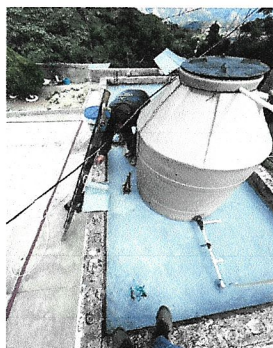
Foto 5: impermeabilización de losa
