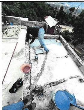
Foto 5: impermeabilización de losa
