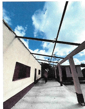
Foto 2: Restauración de estructura e instalación de lamina
