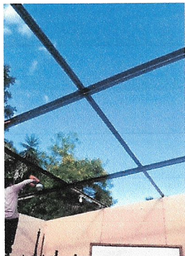
Foto 1: desmontaje de lamina (area de salones de clase)
