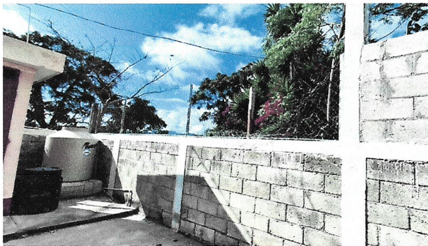
Foto 3: cerco de malla
