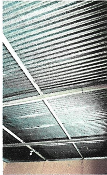
Foto 1: desmontaje de lamina (area de salones de clase)
