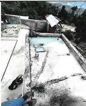
Foto 5: impermeabilización de losa
