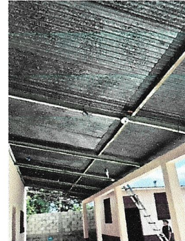
Foto 2: Restauración de estructura e instalación de lamina
