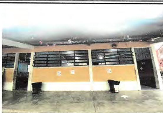
Foto 2: SUSTITUCIÓN DE ESTRUCTURA DE VENTAS EN EL LABORATORIO DE COMPUTACIÓN Y MATENIMIENTO DE LOS BALCONES EN LAS OTRAS AULAS.
