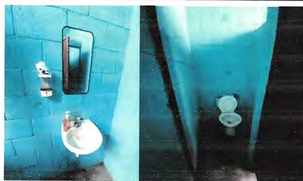
Foto 4: SUSTICIÓN DE LAVAMOS E INODOROS Y SUSTITUCIÓN DE ACCESORIOS DE OTROS INODOROS
