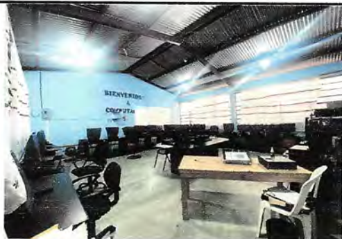
Foto 3: SUSTITUCIÓN DEL PISO DE TORTA DE CEMENTO POR PISO CERÁMICO Y SUSTITUCIÓN DE LÁMPARAS LED
