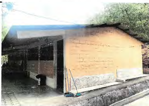
Foto 5: SUSTITUCIÓN DE PINTURA EN EL EXTERIOR DE LAS AULAS
