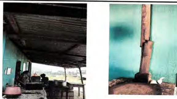
Foto 6: Sustitución de lámina por lámina troquelada con estructura, fundición de pilares para sostener la estructura y en la cocina sustitución de chimenea de metal por concreto
