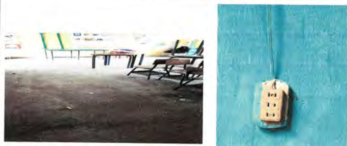
Foto 1: Se realizará sustitución de piso cerámico en aulas y pasillo junto con la Sustitución de lámparas LED en cocina y salones, sustitución de cableado eléctrico y sustitución de toma corrientes
