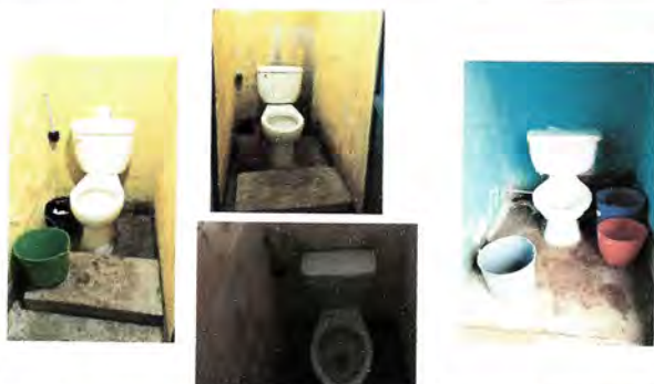
Foto 3: Se realizará sustitución de 2 sanitarios grandes y 2 pequeños, colocación de piso cerámico y se remozará con azulejo en paredes solo a los que tienen problema de humedad y así mejorar la higiene y facilitar al lavar
