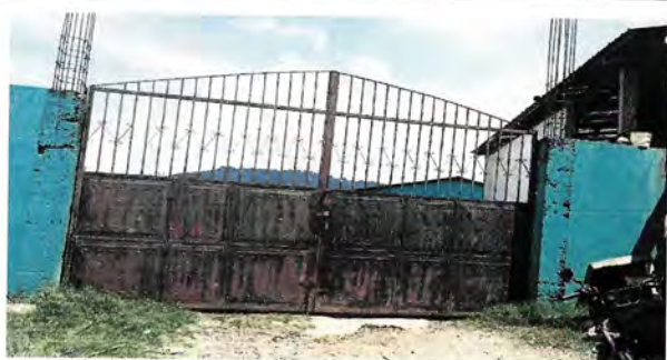
Foto 5: Se realizará soldadura, lija y pintura del portón y se protegerá con viga para reforzar las columnas y se instalará iluminación debido a que es muy oscuro en la noche
