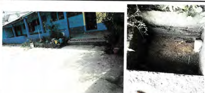
Foto 2: Sustitución de caja de registro, reparación de tapadera de caja y sustitución de tubería PVC, línea principal de aguas negras en 3 baños.
