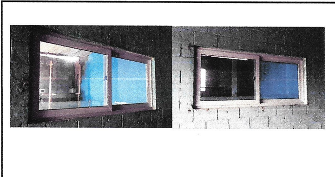
Foto 6: Sustitución de ventanas, (Aula 2 y 3) Sustitución de balcón, (Aula 1)
