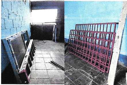
Foto 6: Sustitución de ventanas vidrio ( Aulas 2 y 3 ) y balcón ( Aula 1 )
