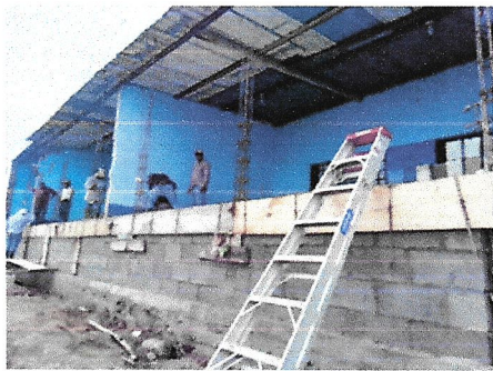
Foto 2: Reparación de muro perimetral, ( Aulas: 1, 2 y 3)
