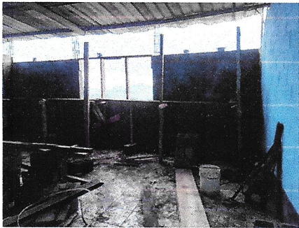
Foto 4: Reparación de muro perimetral, ( Aula: 2 )
