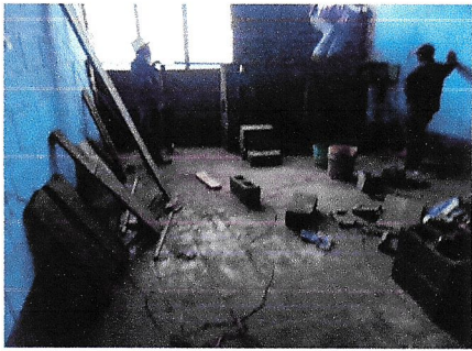
Foto 3: Reparación de muro perimetral, ( Aula: 1 )
