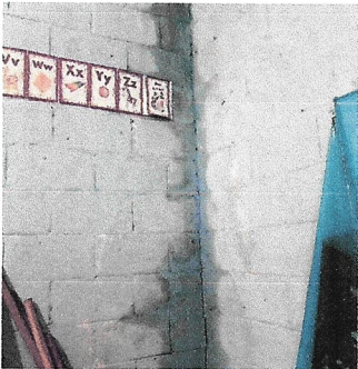
Foto 4: Reparación de muro de contención, (Aula # 3)
