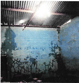
Foto 2: Reparación de muro de contención, (Aula # 1)
