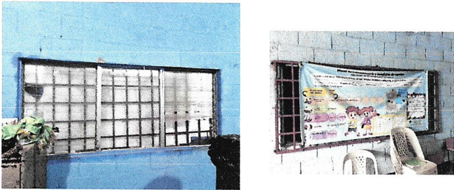
Foto 6: Sustitución de ventanas, (Aula 2 y 3). Sustitución de balcón, (Aula 1)
