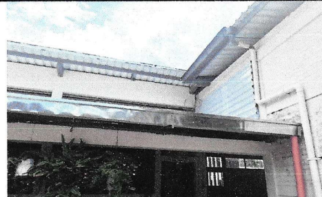
Foto 4: Canal de recolección de agua sobre salon principal de la Escuela, finalizado
