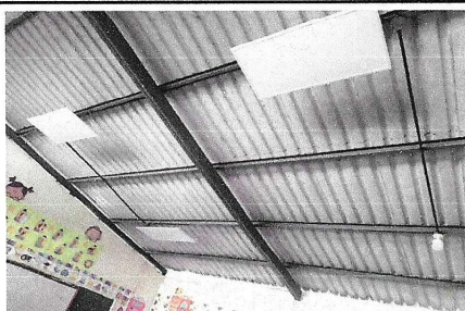
Foto 3: Sistema electrico de aula, finalizado
