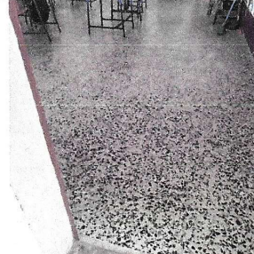
Foto 6: Sustitución de piso, finalizado
