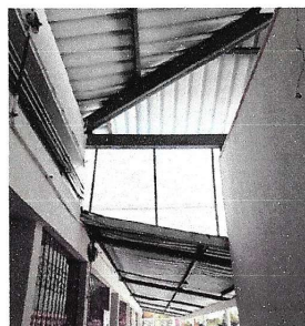
Foto 2: Area de techo finalizado, sobre el pasillo de enfrente de aulas
