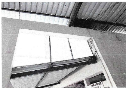
Foto 1: Area de techo finalizado, sobre el pasillo de enfrente de aulas
