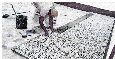
Foto 6: Instalación de piso de granito en el aula
