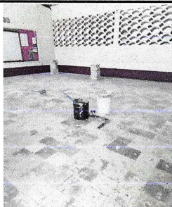
Foto 5: Instalación para reparación piso de granito
