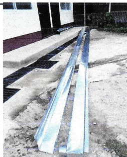
Foto 4: Canal de recolección de agua sobre salon principal de la Escuela, instalación
