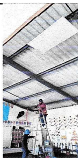
Foto 3: Instalación del sistema electrico de aula
