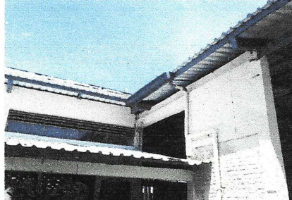
Foto 4: Canal de recolección de agua sobre salon principal de la Escuela
