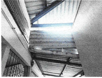
Foto 2: Area de techo, sobre el pasillo de enfrente de aulas
