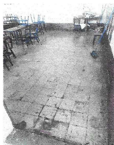
Foto 5: Reparación piso de granito
