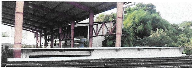
Foto 3: Instalación de estructura de techo de metal e instalación de lámina troquelada en la dirección.
