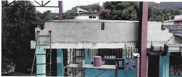
Foto 4: Levantamiento de dos hiladas de block e instalación de estructura de techo de metal e instalación de lámina troquelada en la dirección.
