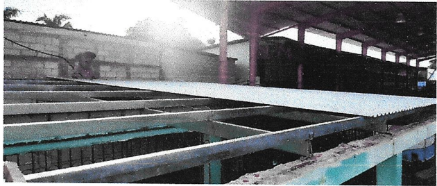
Foto 2: Instalación de estructura de techo de metal e instalación de lámina troquelada.
