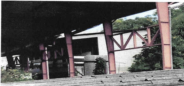
Foto 3: Sustrución de lámina de duralita, por lámina troquelada en la dirección.
