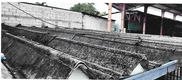
Foto 2: Sustrución de molduras de duralita del laboratorio de computación, por metal para poder anclar la lámina.
