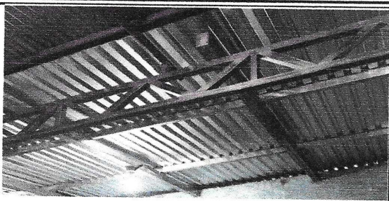
Foto 1: Lámina troquelada aluzinc calibre 26, sustituida
