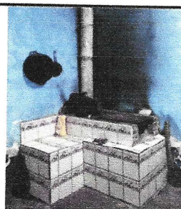
Foto 6: Reparación de Cocina
