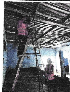
Foto 2: Reparando el sistema eléctrico
