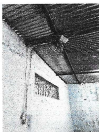
Foto 3: Sustrucción de ventanas por: pvc, vidrio, corrediza y cedazo.
