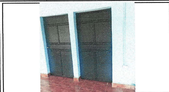
Foto 1: Sustrucción de chapa de puertas
