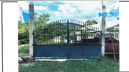
Foto 2: Sustrucción de portón
