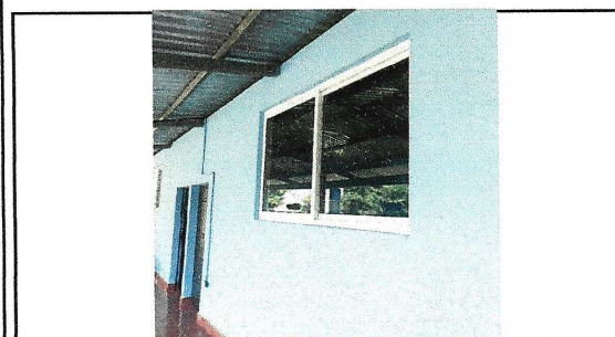
Foto 3: Sustrucción de estructura de metal de ventanas
