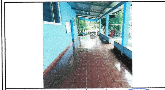
Foto 5: Sustrucción de piso de torta de concreto
