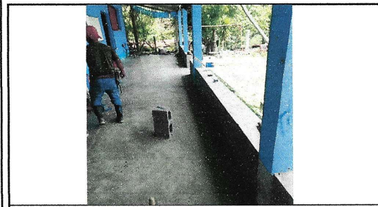
Foto 5: Sustitución de piso de torta de concreto
