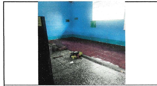
Foto 6: Sustitución de piso de granito
