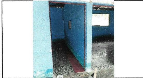
Foto 1: Sustitución de chapa de puertas
