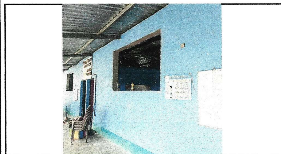
Foto 3: Sustitución de estructura de metal de ventanas
