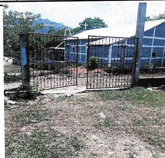
Foto 2: Sustitución de portón
