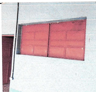
Foto 3: Sustitución de estructura de metal de ventanas
