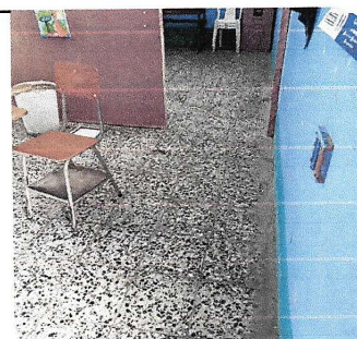
Foto 6: Sustitución de piso de granito
