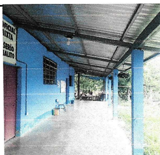
Foto 5: Sustitución de piso de torta de concreto
