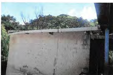
Foto 7: Sustitución de canal PVC por canal de metal
