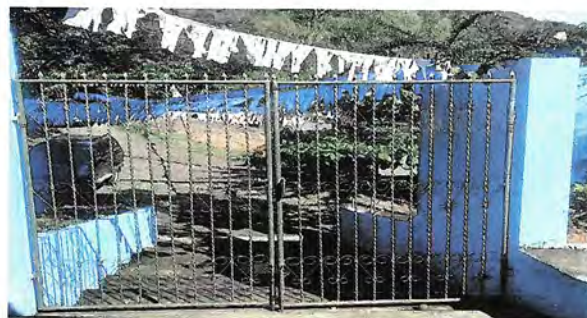
Foto 4: Reparación de portón de entrada con lámina de metal.
