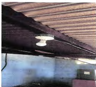
Foto 9: Sustitución de lámpara por lámpara tipo LED
