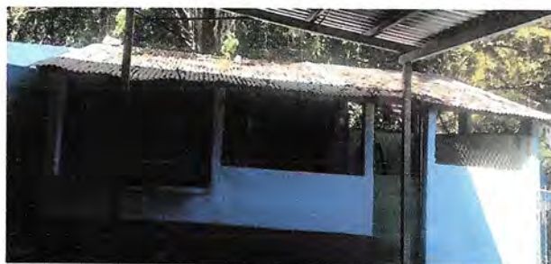
Foto 1: Sustrucción de lámina por lámina troquelada.
