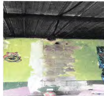
Foto 14: Reparación de ventana de aula.
