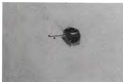
Foto 10: Sustitución de plafoneras en corredor
