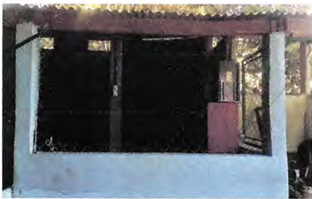
Foto13: Sustrucción de maya por ventana de PVC
