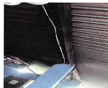
Foto 12: Sustitución de cableado eléctrico
