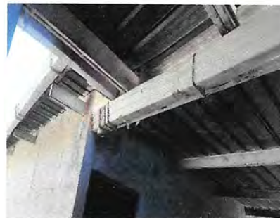
Foto 8: Reparación de caída de agua pluvial tubo PVC 3
