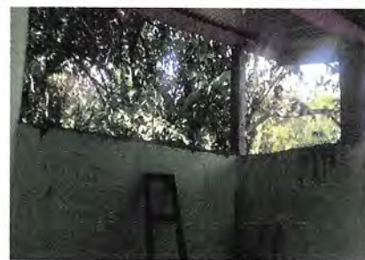
Foto 16: Seguimiento de muro en cocina.
