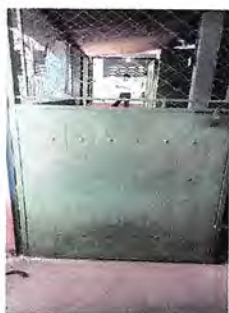
Foto 3: Reparación de puerta de la cocina, sustituir maya por lámina de metal.
