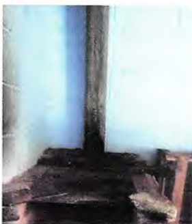
Foto 15: Sustrucción de chimenea de metal por concreto.
