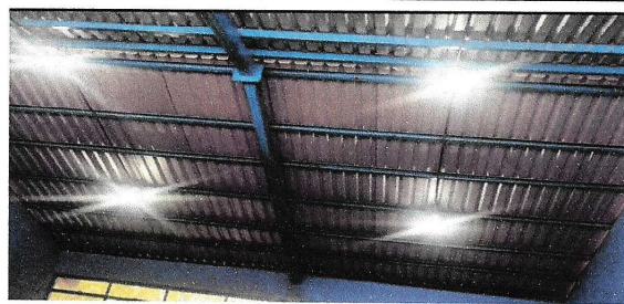
Foto 3: Finalización de instalación de sistema eléctrico
