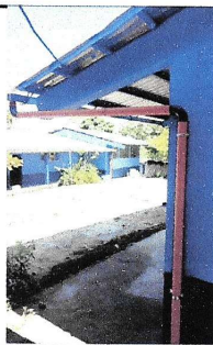
Foto 5: Finalización de canales de bajada de agua pluviales
