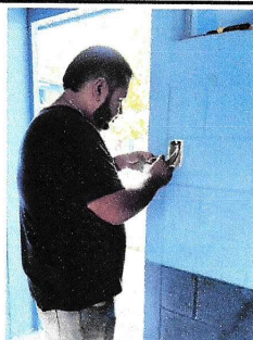
Foto 3: Proceso de sustitución de sistema eléctrico
