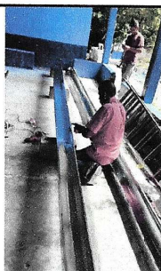
Foto 5: Proceso de canales de bajada de agua pluviales
