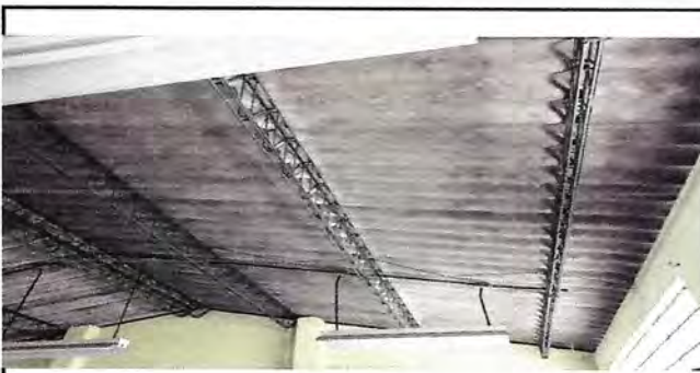
Foto 4: esta es la lámina que se realizará el cambio teniendo esta estructura.
