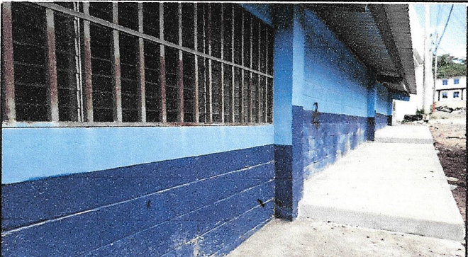
Foto 2: Impermeabilización de muro colindante con calle para evitar filtración de agua, instalación de contrapiso de concreto y reparación de banqueta.
