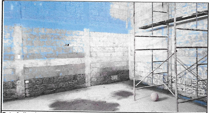
Foto 3: limpieza para repello y cernido en paredes
