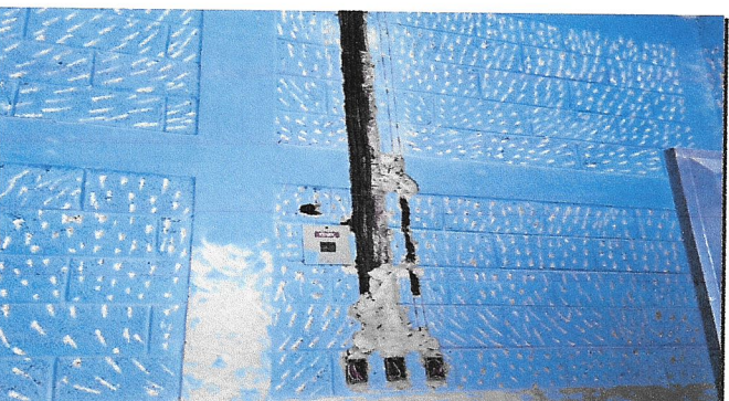
Foto 4: Instalación interna de accesorios en muro.
