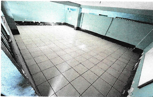
Foto 6: Se colocó piso cerámico
