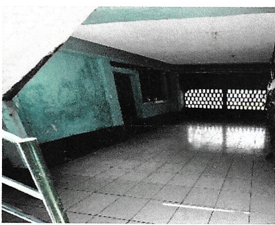
Foto 2: Sustitución de piso cerámico
