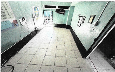
Foto 4: Sustitución de piso cerámico
