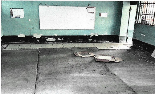
Foto 6: Se colocará piso cerámico
