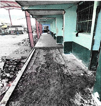
Foto 3: Se realizará sustitución de piso cerámico
