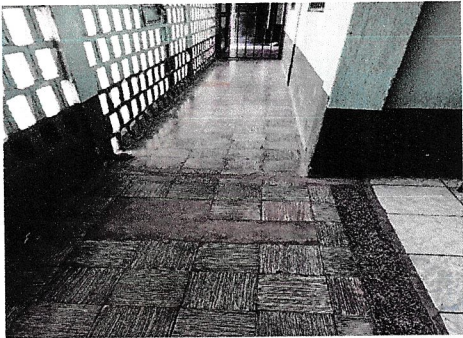
Foto1: Se realizará sustitución de piso cerámico
