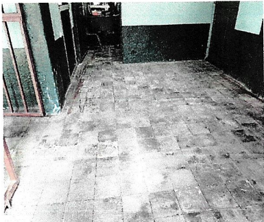
Foto 4: Se realizará sustitución de piso cerámico
