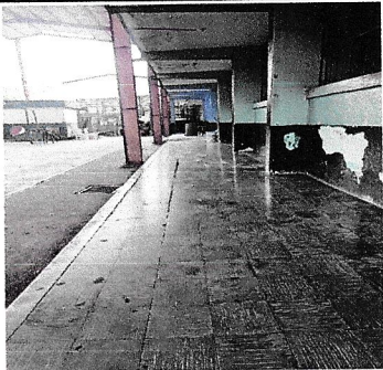
Foto 3: Se realizará sustitución de piso cerámico
