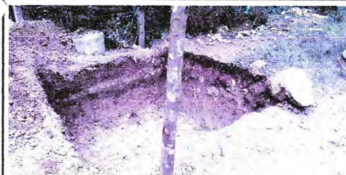
Foto 5: seguimiento y remozamiento de fosa, muro e instalación de tubería
