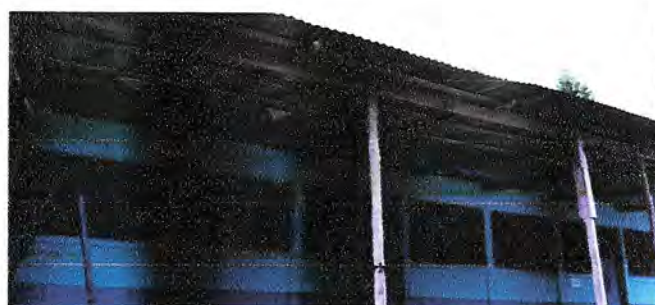
Foto 2: Sustrucción de Estructura, lámina, canal, capotes y bases de madera por estructura metálica de corredor y cocina.
