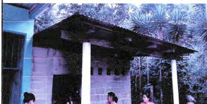
Foto 3: Sustrucción de Estructura, lámina, canal, capotes y bases de madera por estructura metálica de corredor y cocina.
