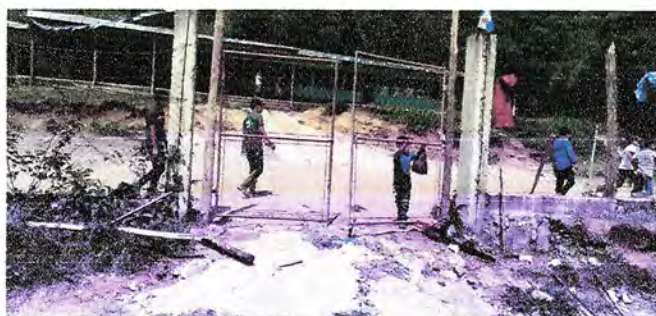
FOTO 1 Sustrucción de portón
