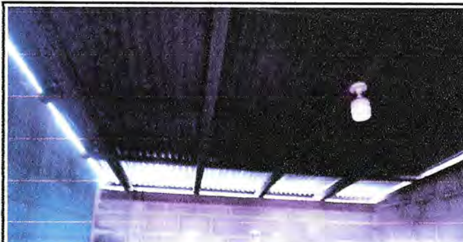
Foto 4: Sustrucción de Estructura, lámina, canal, capotes y bases de madera por estructura metálica de corredor y cocina.
