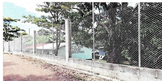
Foto 4: Vista del muro remozado finalizado
