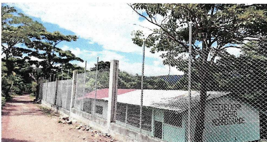
Foto 5: Vista del muro remozado finalizado
