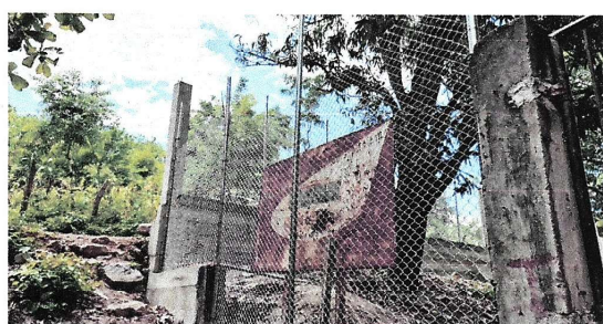
Foto 6: Muro perimetral de frente finalizado
