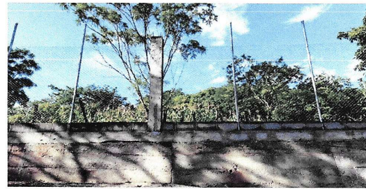
Foto 2: parte del muro central finalizado
