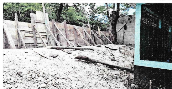
Foto 3: Levantado del muro
