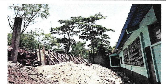
Foto 4: Vista del muro en remozamiento
