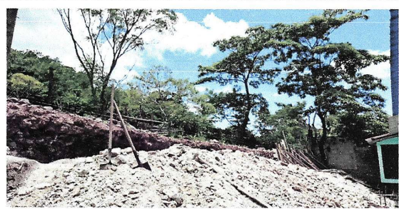
Foto 2: Retiro de muro anterior
