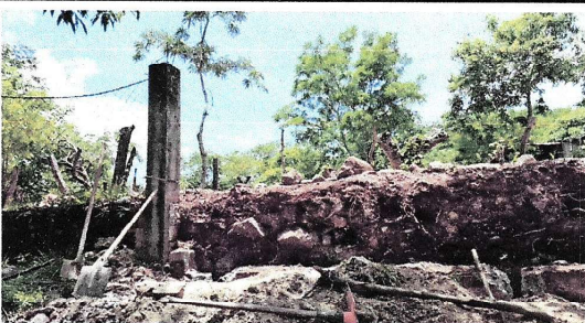
Foto 5: Avance de remozamiento en el muro
