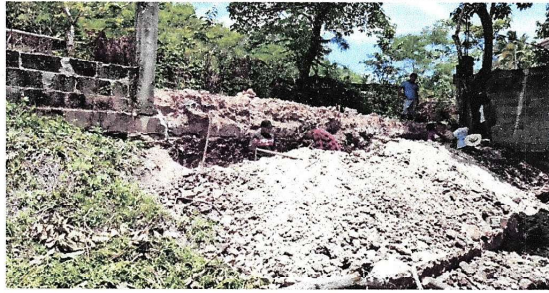
Foto 1: Inicio de Remozamiento
