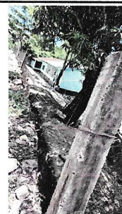
Foto 6: Avance en remozamiento del muro y columnas
