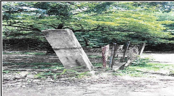
Foto 1: Muro perimetral de frente
