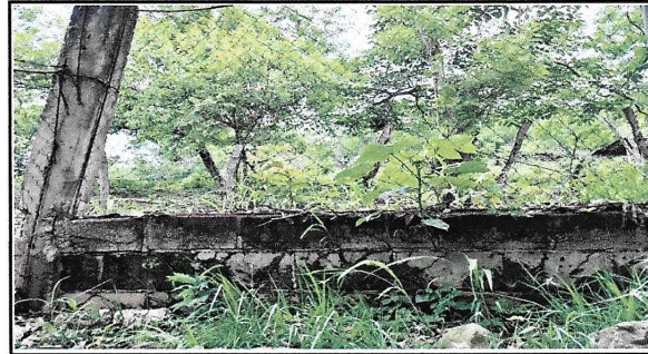
Foto 2: Muro perimetral de adentro de la escuela
