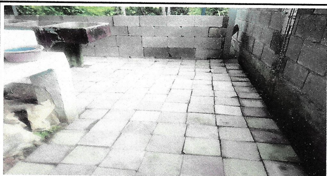
Foto 5: SUSTITUCIÓN DE PISO POR LOSA DE CEMENTO EN EL AREA DE COCINA
