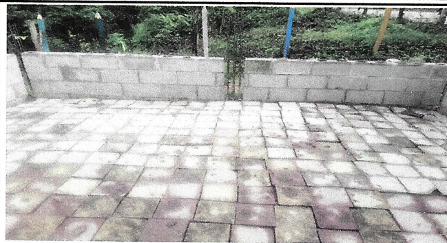
Foto 1: SUSTITUCIÓN DE PISO POR PISO DE GRANITO EN AREA DEL AULA DE PÁRVULOS
