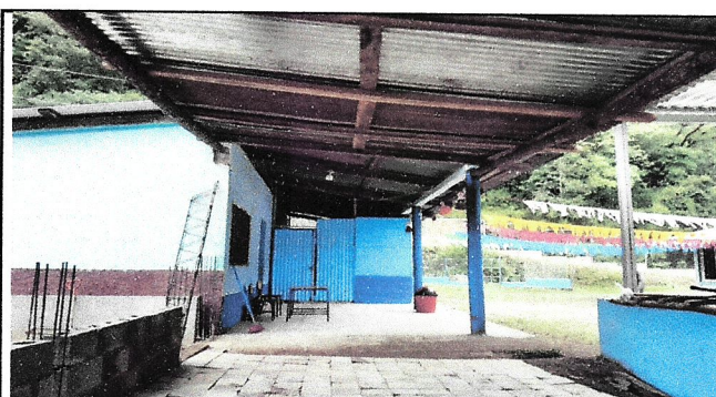
Foto 4: SUSTITUCIÓN DE TECHO DE ESTRUCTURA DE MADERA POR TECHO DE ESTRUCTURA METALICA Y LAMINA TROQUELADA AREA DEL CORREDOR DEL AULA DE PÁRVULOS
