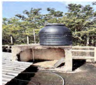
Foto 4: Sustitución de deposito de agua.
