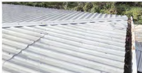
Foto 3: Sustitucion de canales de metal.
