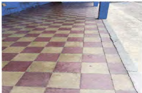
Foto 5: Sustitución de piso de corredor y dos aulas por cerámica.
