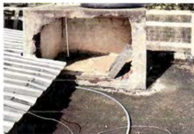
Instalacion de estructura
