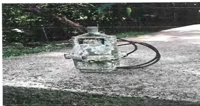
Foto 4: SUSTITUCIÓN DE BOMBA
