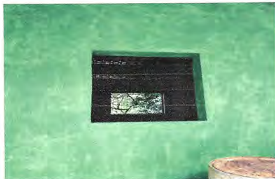
Foto 2: SUSTITUCIÓN DE BALCÓN DE METAL COCINA
