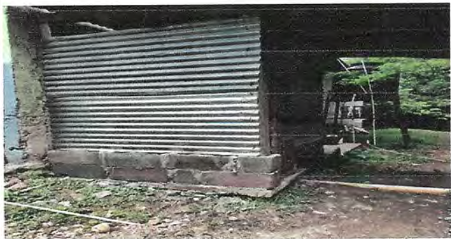
Foto1: REMODELACIÓN DE BAÑOS, LAVAMANOS Y PILA.
