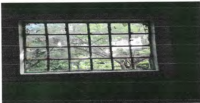
Foto 5: SUSTITUCIÓN DE VENTANA CERRADA CON VIDRIO, POR METAL
