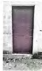
Foto 4: SUSTITUCIÓN DE PUERTA DE MADERA POR METAL
