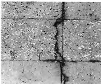
Foto 3: SUSTITUCIÓN DE PISO DE GRANITOS
