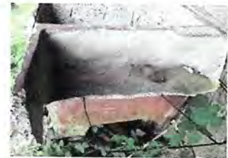
Foto 6: SUSTITUCIÓN DE PILA existente en mal estado por pila de bloc, incluye retiro de la actual limpieza materiales y mano de obra
