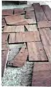
Foto 1: REPARACIÓN DE AZULEJOS EN MUEBLES DE COCINA
