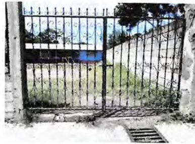
Foto 2: SUSTITUCIÓN DE PORTÓN
