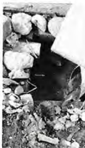
Foto 5: MANTENIMIENTO A CAJA DE REGISTRO
