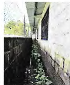
Foto 6: COLOCACIÓN DE CANALES POR EXCESO DE HUMEDAD
