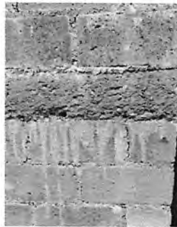
Foto1: SELLADO DE GRIETAS
