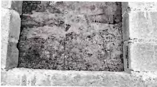
Foto 3: SUSTITUCIÓN DE VENTANA DE MADERA POR METAL
