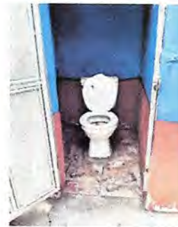
Foto 2: SUSTITUCIÓN DE INODOROS
