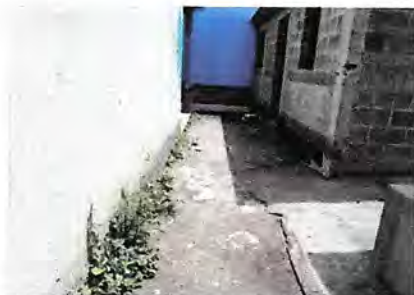
Foto 5: REMODELACIÓN DE 30 METROS CUADRADOS DE LOSA DE PATIO
