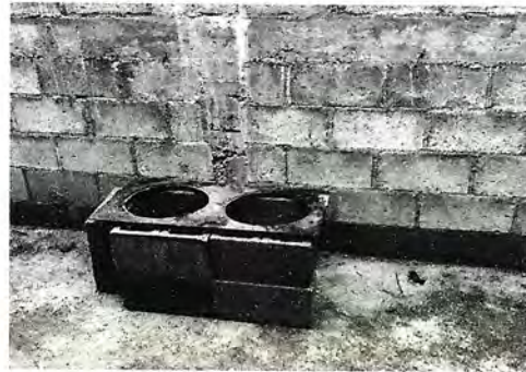
Foto 4: INSTALACIÓN DE ESTUFA RURAL COMPLETA
