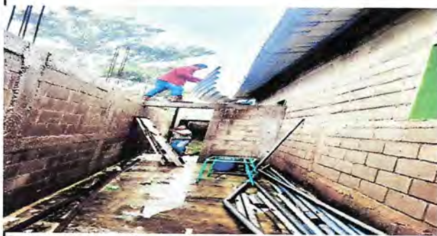
Foto 1: CUBIERTA DE LAMINA Y PISO DE CONCRETO
