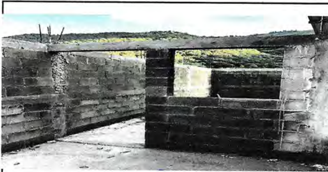
Foto 3: PUERTAS DE METAL E INSTALACIÓN DE VENTANA
