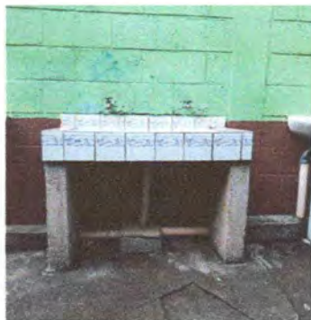
Foto 9: Servicios sanitarios y sus accesorios (mantenimiento a estructura, sustitución de inodoros, sustitución de grifos), y reparación de drenajes.
