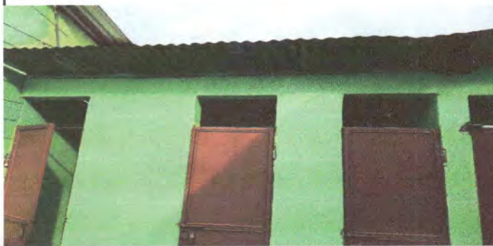
Foto 1: Sustrucción de lámina en el área de los sanitarios.
