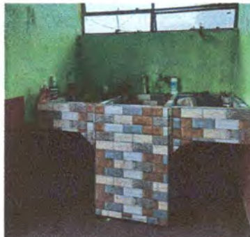
Foto 11: Sustitución de pila.
