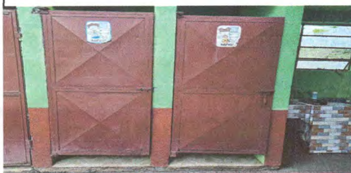
Foto 3: Puertas de Metal: Mantenimiento a estructura y sustrucción de 2 puertas en servicios sanitarios.
