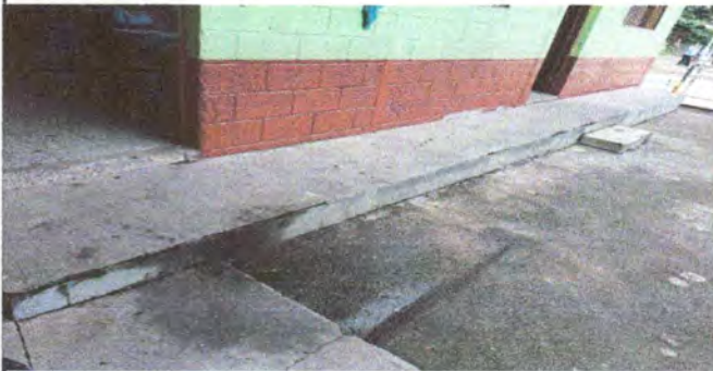
Foto 7: Reparación de banqueta de concreto.
