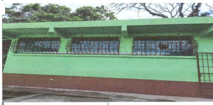
Foto 5: Sustrucción de vidrios.
