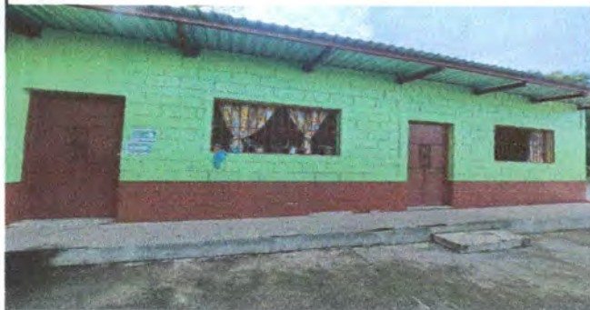
Foto 8: Pintura en muros exteriores e interiores.
