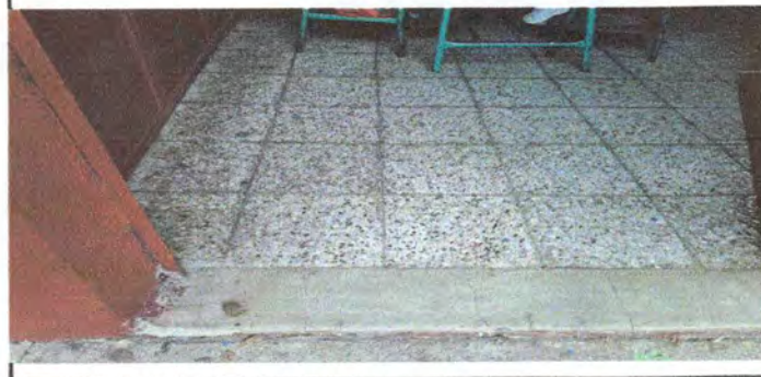
Foto 6: Sustrucción de piso de granito.
