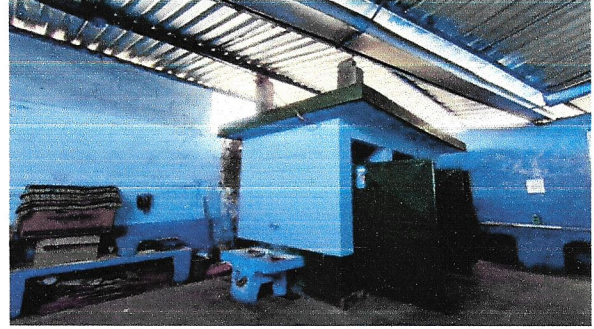
Foto 2: Sustrucción de lámina, por lanima troquelada aluzinc, calibre 26 de aula, corredor y entrada principal. 109 M2
