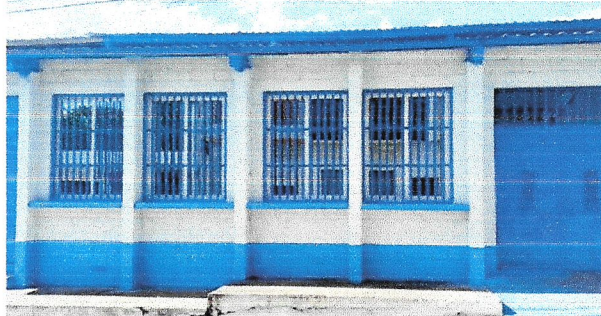
Foto 10: Fabricación e instalación de 7 balcones de hierro en ventanas.
