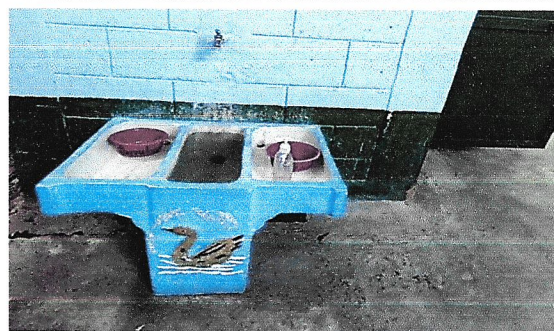
Foto 12: Sustrucción de pila de cemento de dos lavaderos grande por pila pequeña.
