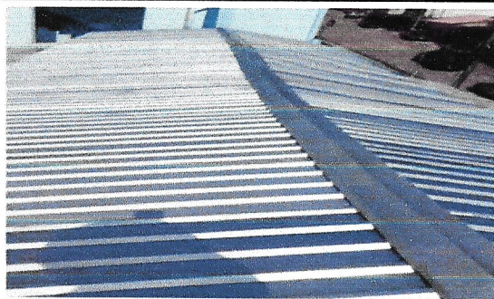
Foto 11: Desinstalación de lámina existente
