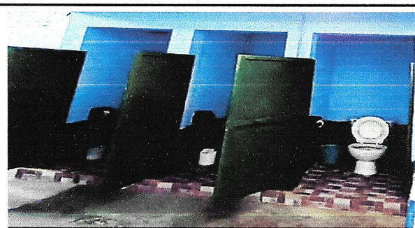
Foto 6: Sustrucción de piso por piso cerámico (un aula y tres baños, 60 M2)
