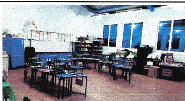
Foto 5: Sustrucción de piso de cemento líquido, por piso cerámico (1 aula y 3 baños. 60 M2)
