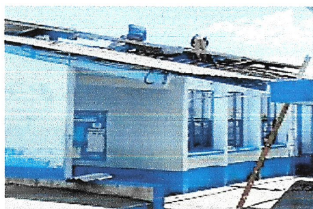
Foto 11: Desinstalación de lámina existente
