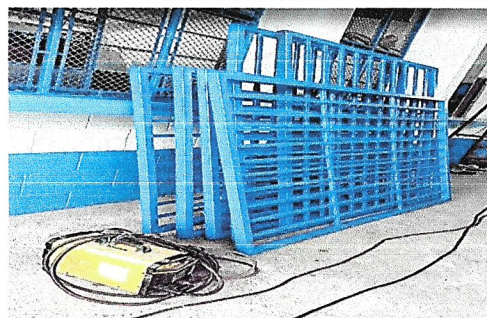
Foto 10: Fabricación e instalación de 7 balcones de hierro en ventanas.
