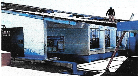
Foto 1: Sustitución de lámina, por lámina troquelada aluzinc, calibre 26 de aula, corredor y entrada principal. 109 M2
