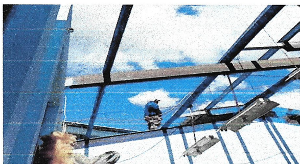
Foto 3: Mantenimiento a estructura de soporte de metal (pintura de estructura metálica) 109 M2
