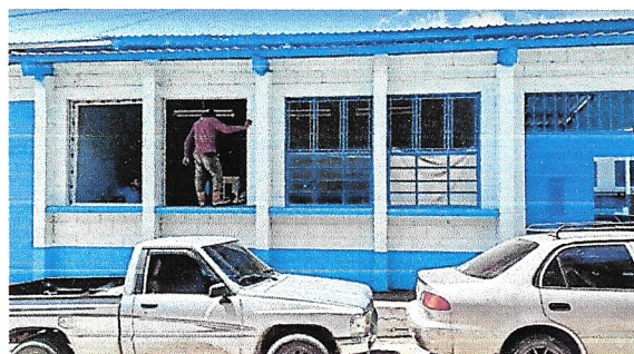
Foto 9: Fabricación e instalación de 7 ventanas de PVC
