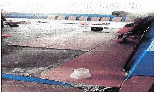
Foto 5: Sustitución de piso de cemento líquido, por piso cerámico (1 aula y 3 baños. 60 M2
