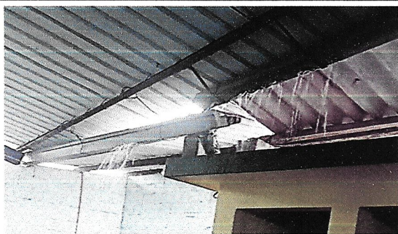
Foto 7: Sustrución de canal de metal de aluzinc . (14 M lineales)
