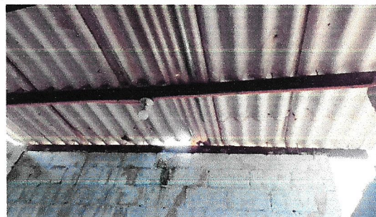
Foto 2: Sustitución de lámina, por lanima troquelada aluzinc, calibre 26 de aula, corredor y entrada principal. 109 M2
