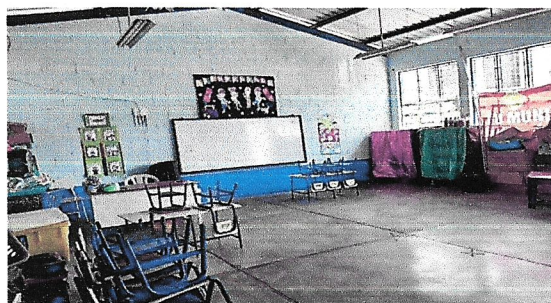
Foto 5: Sustitución de piso de cemento líquido, por piso cerámico (1 aula y 3 baños. 60 M2)
