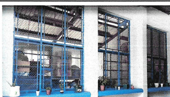
Foto 10: Fabricación e instalación de 7 balcones de hierro en ventanas.
