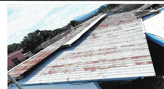
Foto 11: Desinstalación de lámina existente
