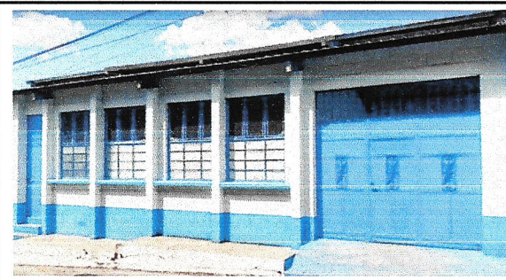
Foto 9: Fabricación e instalación de 7 ventanas de PVC
