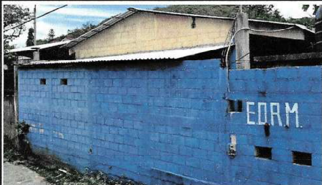
Foto1: CUBIERTA DE LÁMINA
