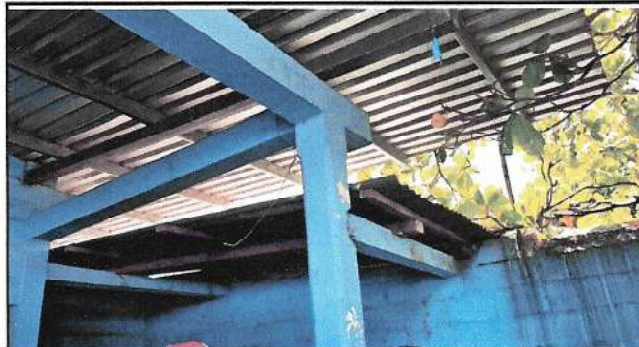
Foto 2: ESTRUCTURA DE TECHO
