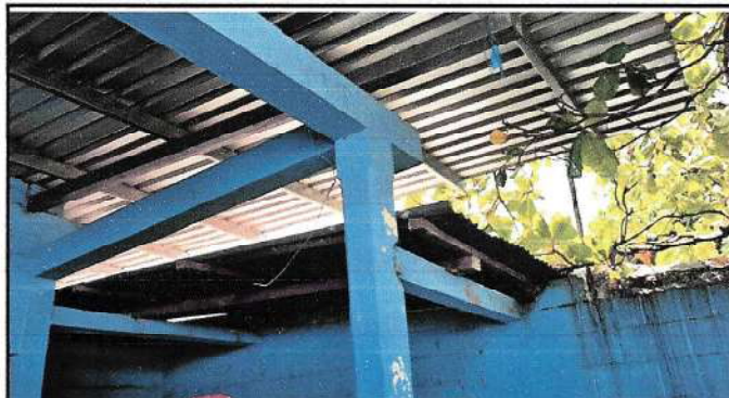
Foto 2: ESTRUCTURA DE TECHO
