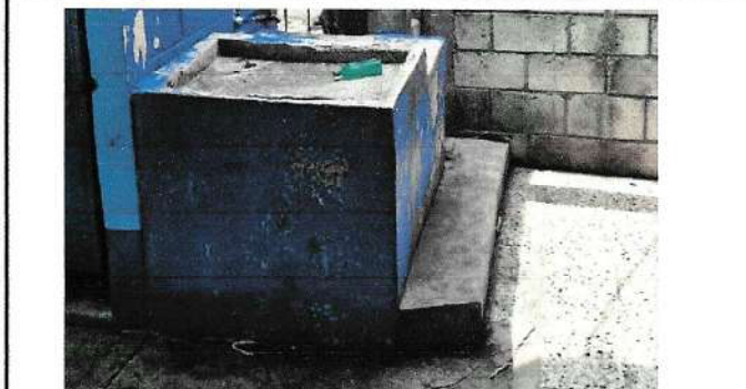
Foto 6: PILA DE COCINA
