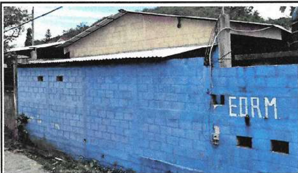
Foto 1: CUBIERTA DE LÁMINA
