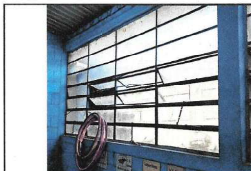
Foto 4: BALCONES Y VENTANAS
