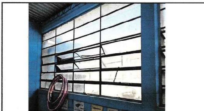
Foto 4: BALCONES Y VENTANAS
