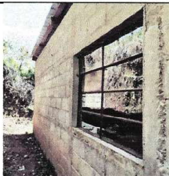
Foto 4: BALCONES EN VENTANAS
