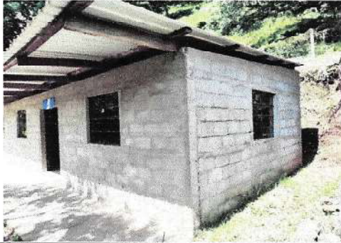
Foto 1: CUBIERTA DE LÁMINA
