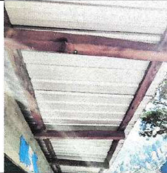
Foto 2: ESTRUCTURA DE TECHO
