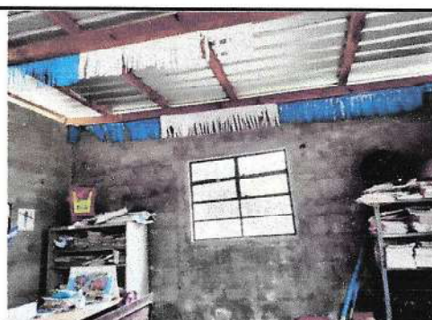
Foto 6: SELLADO DE GRIETAS
